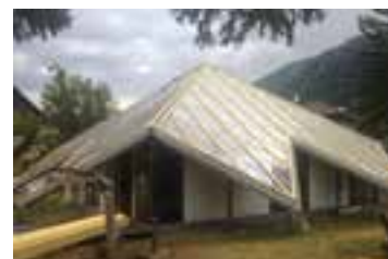
Réfection toiture du mille club
