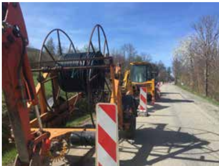
Enfouissement de la fibre au printemps 2017
