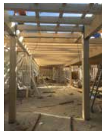
Toiture terrasse en bois des Alpes
