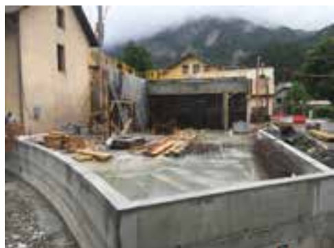
Construction de la bibliothèque (été 2017)
