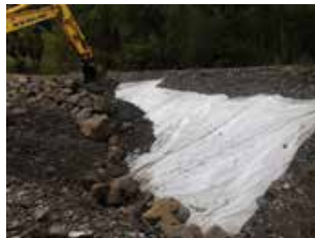
Pose d'une membrane géotextile
