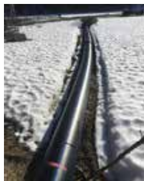
Mise en route de la pompe des « Choullières » le 4 décembre
