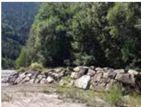
L'épi du Dauphin 2 avant travaux
