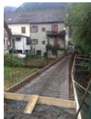
Rampe permettant l'accessibilité
