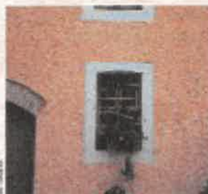
Photo : G. A. B. 03 Réhabilitation de façade
