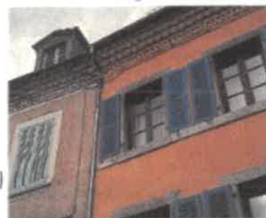
Génoises, enduits et menuiseries colorés
