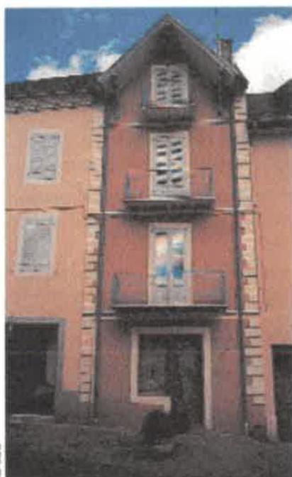
Saint-Dorner, enduits colorés et décors de façades (encadrement de fenêtre, chaînages d'angle...)
