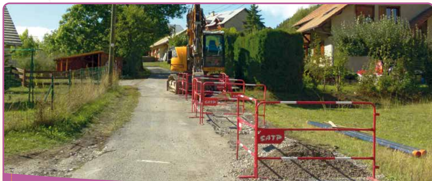
✿ Travaux à Ruisseau Lacour
