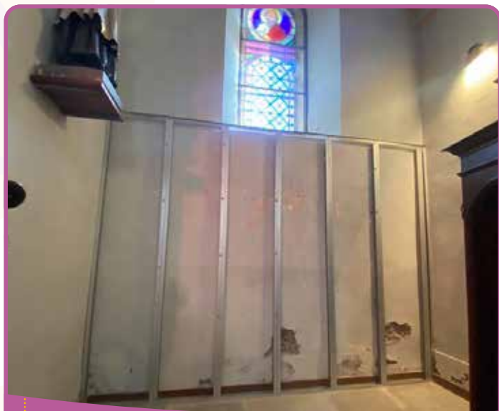
Des travaux dans l'église Saint-Jean
