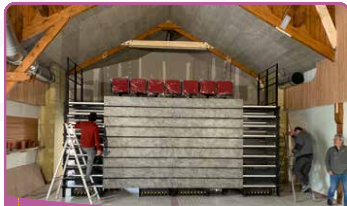
✿ Les gradins en cours de montage
