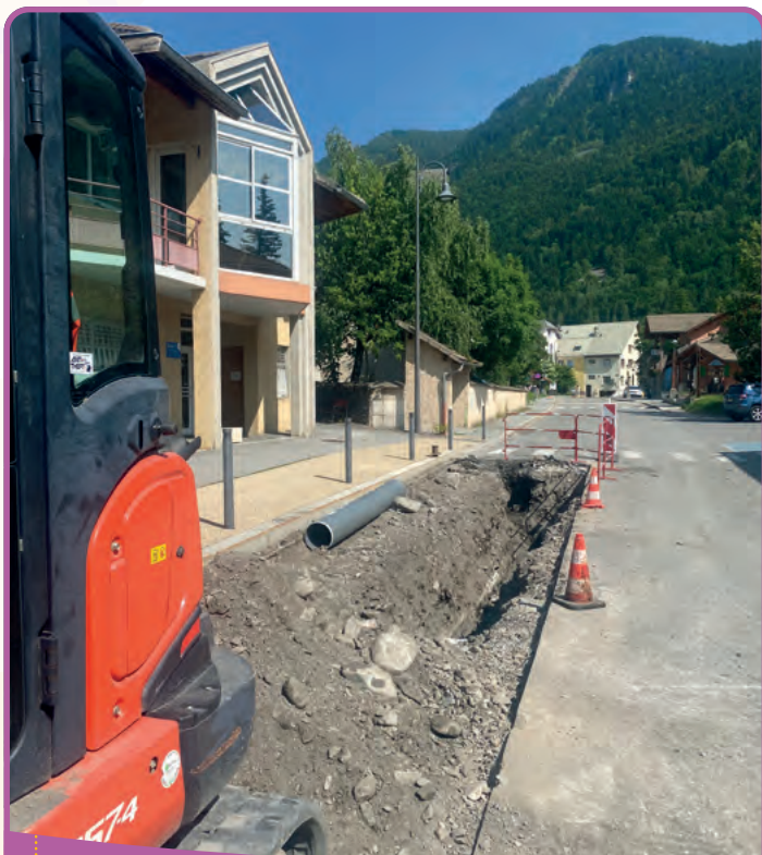
Travaux sur le réseau route de St Jean
