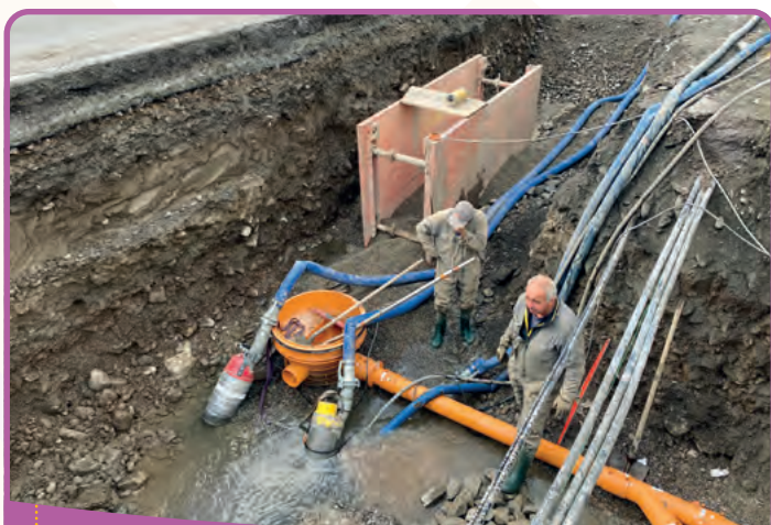
Travaux sur le réseau d'assainissement aux Foulons
